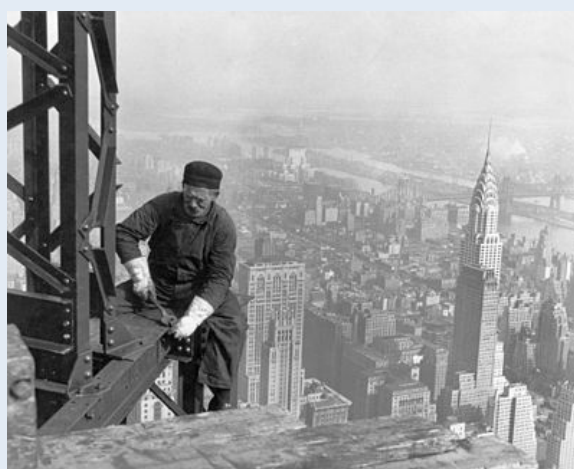
一名正在建造帝国大厦的建筑工人
