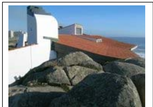
Der Boa Nova Tee Pavillon integriert sich in die Landschaft
