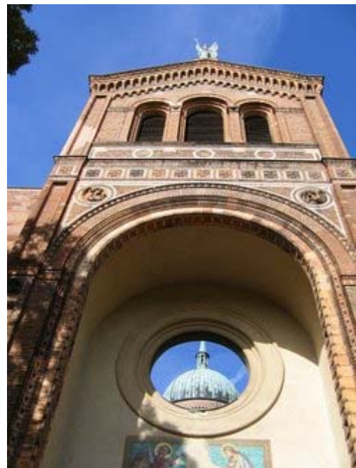
Die Hauptfassade der Sankt-Michaelskirche von vorne. Weil das Dach zerstört wurde, ist durch das Portalfenster die Kuppel zu sehen. Darüber das dreifenstrige Glockengeschoss. Ganz unten ist das Mosaik mit der Verkündigung zu sehen. Wegen dem überstehenden Eingang hat es die Zerstörungen teilweise überstanden.
