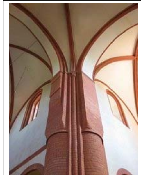
Kirche, nordöstlicher Vierungsnfeiler
